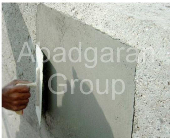
روش مصرف ترمیم‌کننده بتن E.M.REPAIR
